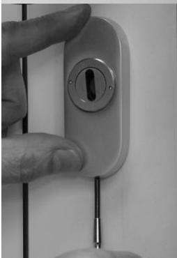
Setzen Sie jetzt die Zylinderschutzrosette auf die Unterplatte. Schrauben Sie mit einem entsprechenden Schraubendreher die Einstellschrauben nach außen (**Drehrichtung links**) bis die Zylinderschutzrosette fest anliegt.
