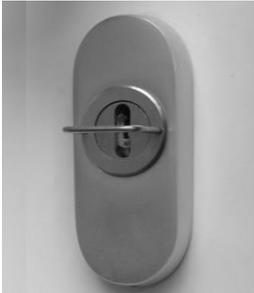
Halten Sie die Zylinderschutzrosette mit dem Zylinderschutz über den Profilzylinder. Mit dem beiliegenden Hilfswerkzeug stellen Sie den Zylinderschutz auf die entsprechende Höhe ein. Wenn Sie die richtige Höhe eingestellt haben, drehen Sie den Zylinderschutz um 180° nach links und legen Sie Rosette vorsichtig zur Seite.
